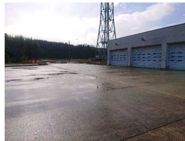
▲ 仮置場候補地の様子
