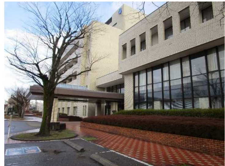
▲ 七尾市役所 外観
